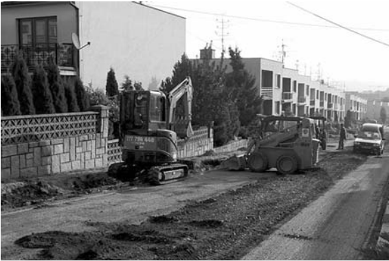
Ulice Nová se brzy dočká nové vozovky. Foto: Ing. Zdeněk Karber
