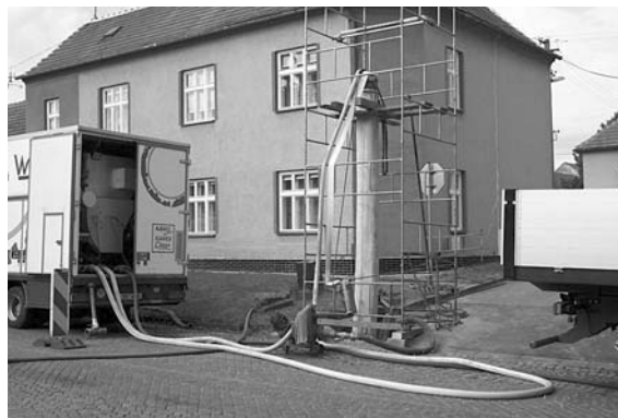
Rekonstrukce kanalizace na ulici Hlavní naproti ZUŠ.
